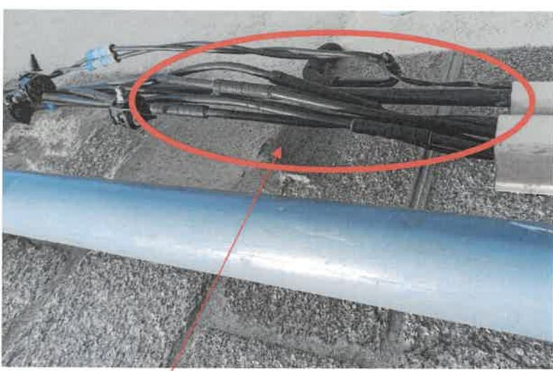
Raccordement neuf aéro-souterrain triphasé type 2 (Branchement Provisoire Fixe). Réaliser une descente en 4 fils après implantation d'un coffret de coupure et un Coffret Grand Volume avec un linky et un disjoncteur 30A60 type S.
